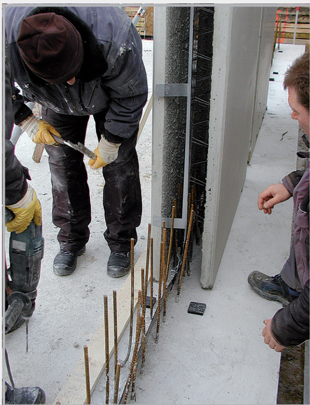
Instaluje se dutá stěna, při tom těsnicí plech MASTER vytváří utěsnění základů/zedí.
