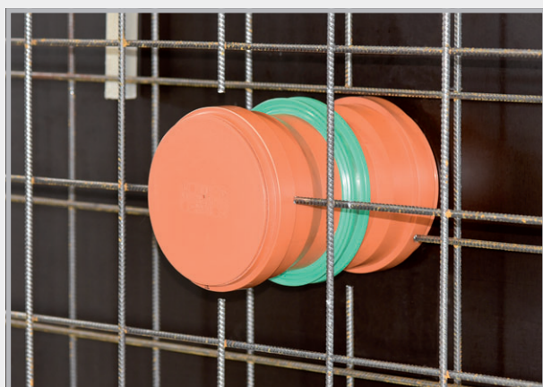
Čelní pohled, nainstalovaná potrubní průchodka
