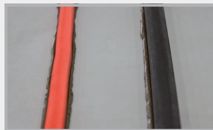
MasterColl pro bentonitové bobtnající pásy a FLOWSTOP
