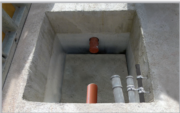
Po betonování: Světle šedá je jímka čerpadla, tmavošedé jsou betonované základy.
