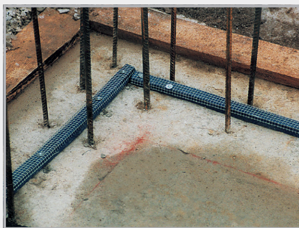
Pokládka pomocí upevňovací mřížky a hřebíků
