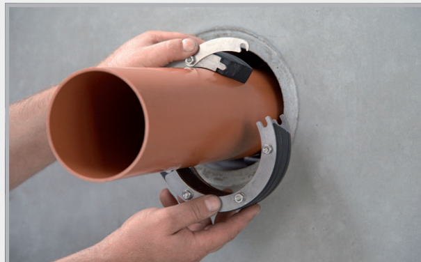
Montáž děleného provedení
