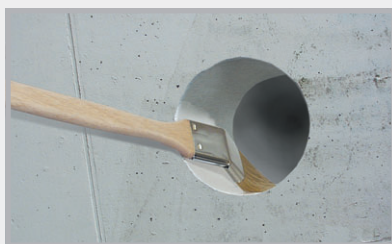
Nařete epoxidovou pryskyřicí PROTECT
