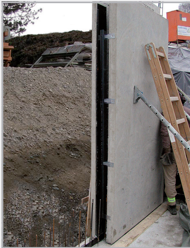
Utěsnění zedí/zedí se provádí u každého prvku.
