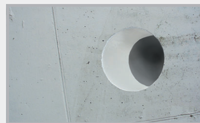
Trvale chráněn epoxidovou pryskyřicí PROTECT
