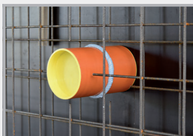
Prostup připravený pro betonování
