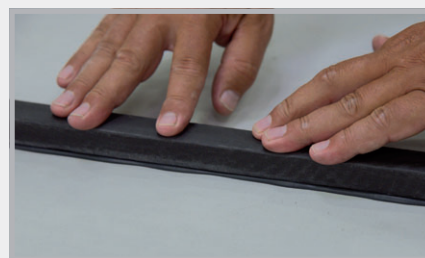
Bobtnající pásek zatlačte do lože lepidla
