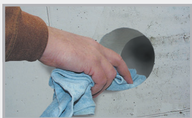
Odstraňte z jádrového otvoru prach
